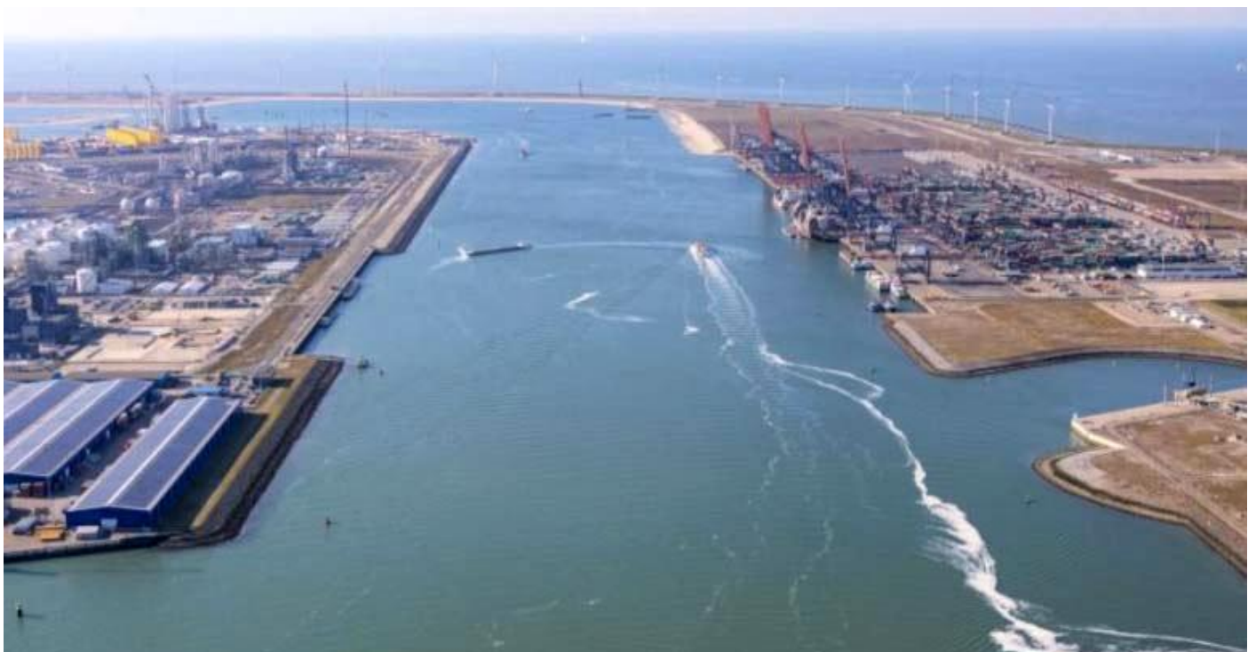
Combinatie Hakkers, Van Oord en De Klerk legt sleperskade aan in Yangtzekanaal
