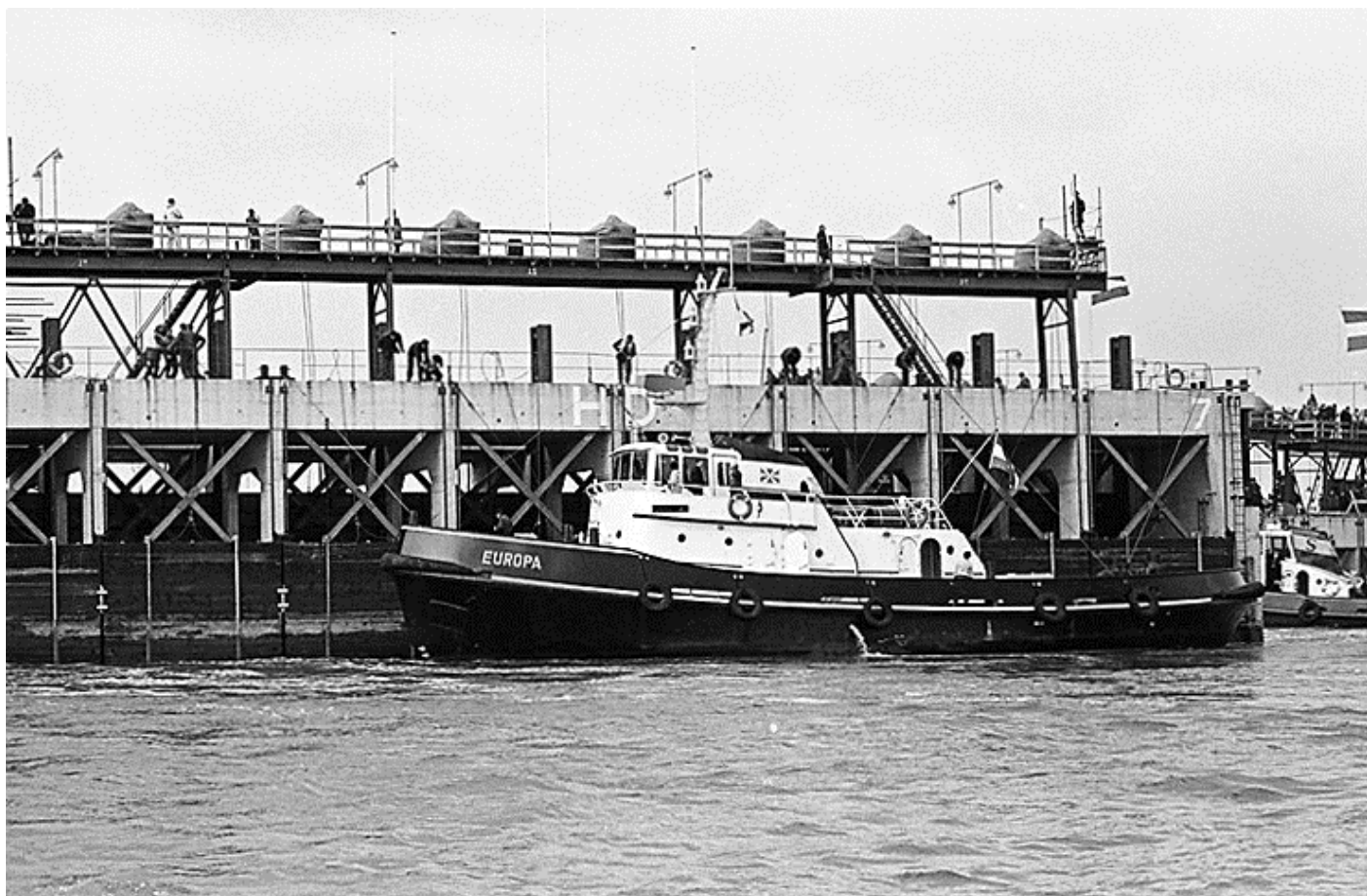
EUROPA, plaatsing van het laatste caisson, bouw Volkerakdam foto: Aart Klein, 4-1969, Nederlands Fotomuseum
